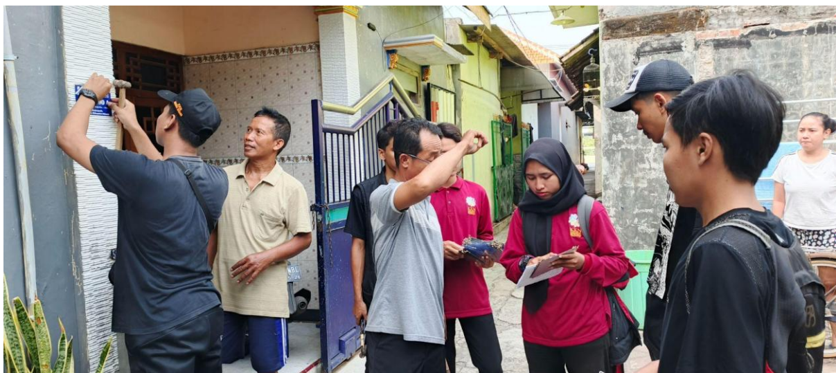
Gambar 1. Pemasangan Plakat Nomor Rumah
