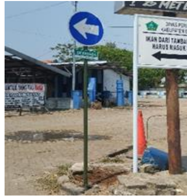
Gambar 4. Pemasangan Petunjuk Arah
