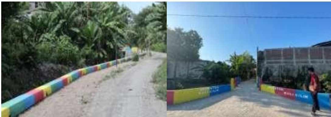
Gambar 2. Hasil Pengecatan Tepi Sungai dan Jembatan
