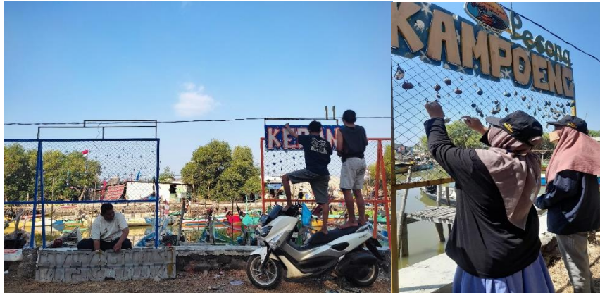
Gambar 3. Renovasi dan Pembangunan Spot Foto
