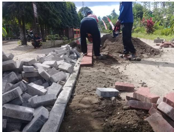
Gambar 2. Pemasangan paving
