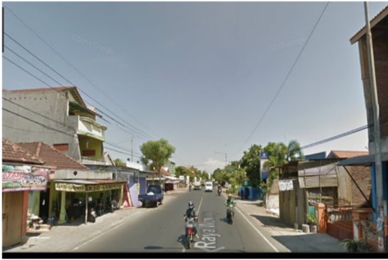
Gambar 2. Kondisi Bahu Jalan di Kecamatan Wonoayu Kab. Sidoarjo
